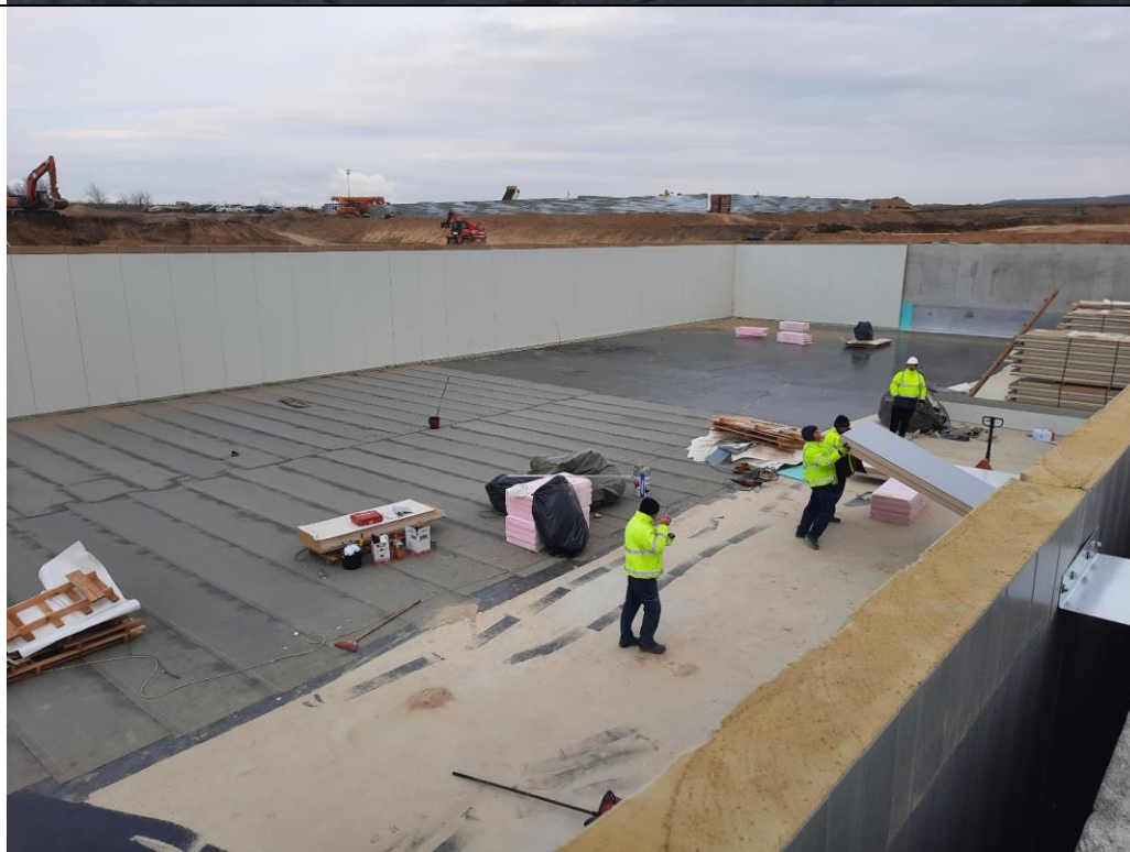
Montaj termoizolatie si hidroizolatie pardoseala
